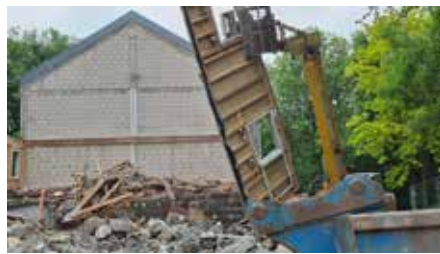
Im April wurde mit dem Abriss begonnen... Foto: SGS GmbH
